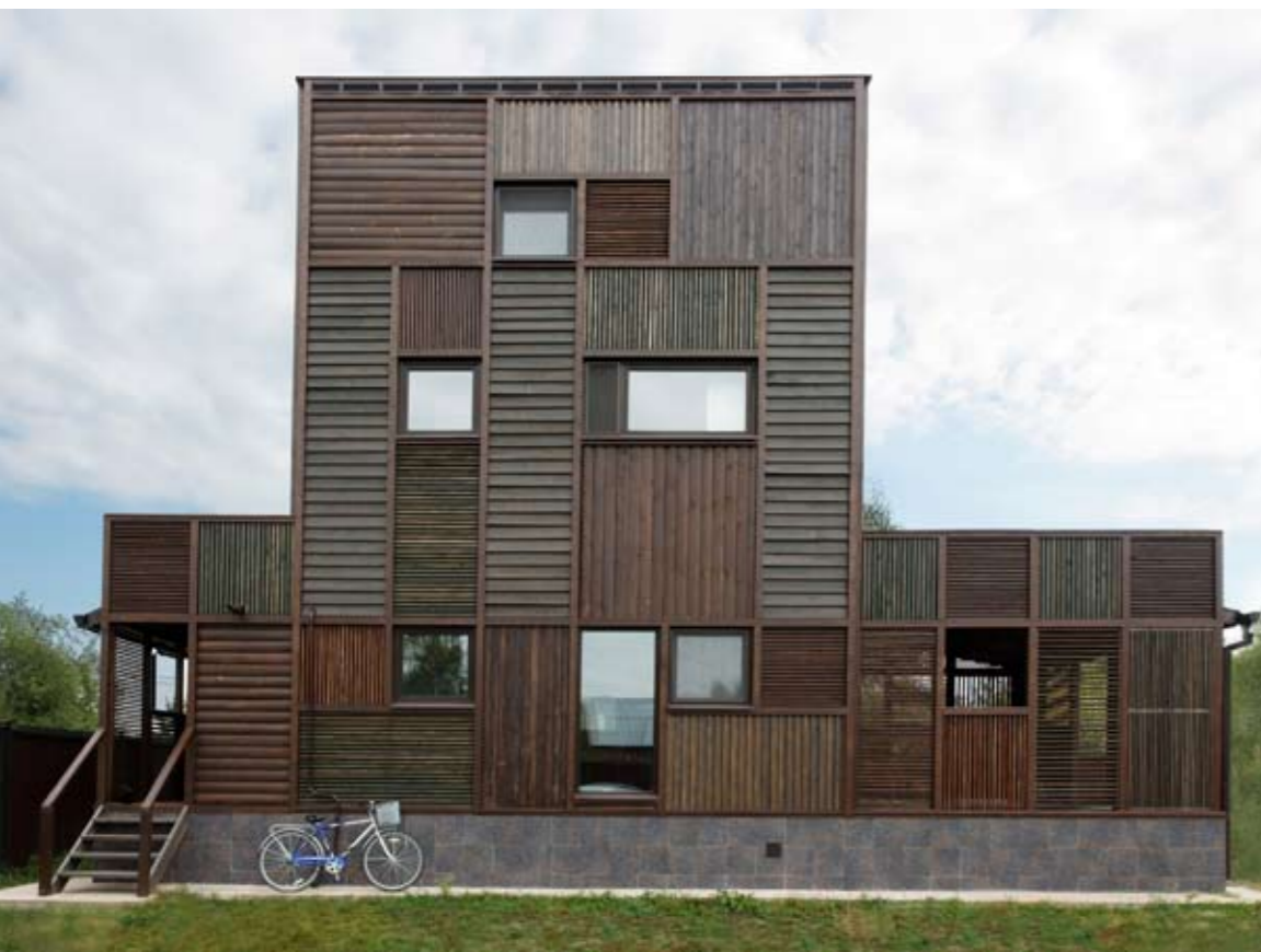
Művészi homlokzat: a különbözőképpen forgatott, többféle színárnyalatú, struktúrájú és méretű falburkoló panelek változatos felületet hoznak létre
